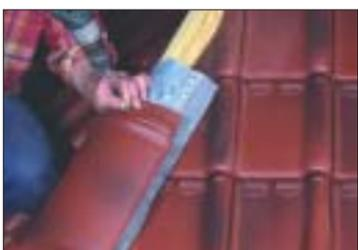
Après coupe des tuiles d'approche, pose du closoir ventilé sur lisse de réhausse et fixation des arêtiers, par vis et rondelle d'étanchéité.
