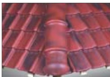
Arêtiers et about d'arêtier à emboîtement posés à sec, sur closoir ventilé, sans emploi de mortier.
