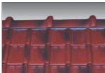
Faîtage réalisé à sec avec faitières 1/2 rondes à emboîtement et closoir ventilé, sans emploi de mortier.
